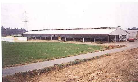
新設フリーストール全景
