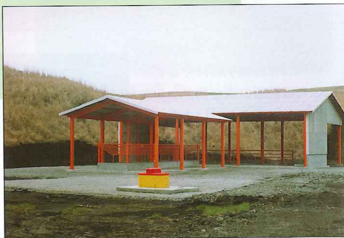
退避舎と給水施設
